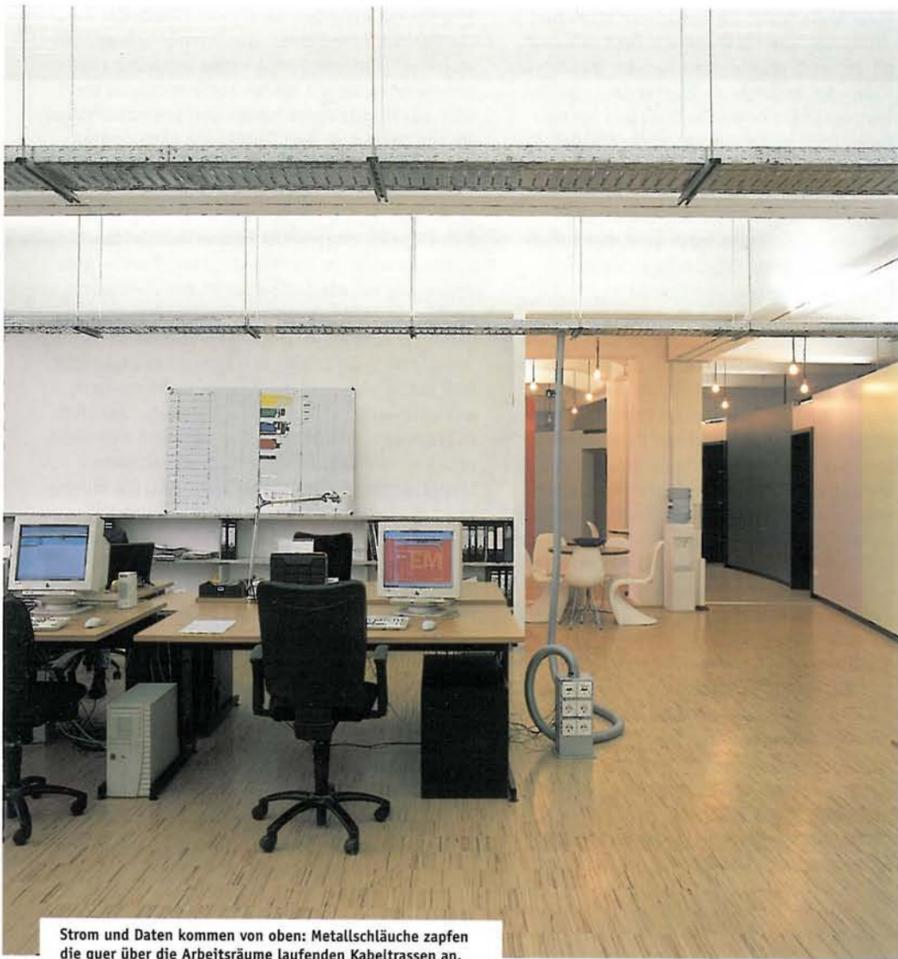
Strom und Daten kommen von oben: Metallschläuche zapfen die quer über die Arbeitsräume laufenden Kabeltrassen an.
