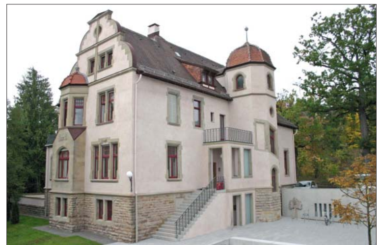
In der denkmalgeschützten Villa Bruns befinden sich nach der Renovierung nun Büro- und Gruppenräume.
